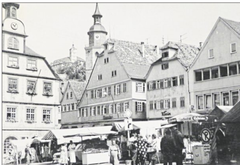
Die Ansicht der Nordseite des Vaihinger Marktplatzes an einem Markttag in den 1960er-Jahren und 2022. Im Gemeinderat kam jetzt wieder der Vorschlag auf, die Lücke, die durch den Abbruch des Hauses Marktplatz 8 (Gemischtwarengeschäft Klein) entstand, zu schließen.
